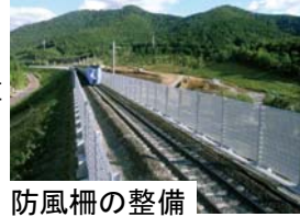
防風柵の整備
